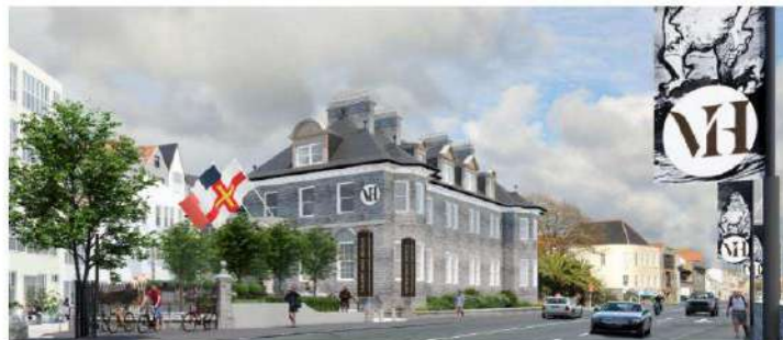
■ Le projet de Centre Victor Hugo dans l'ancien bâtiment des Bureaux des États
